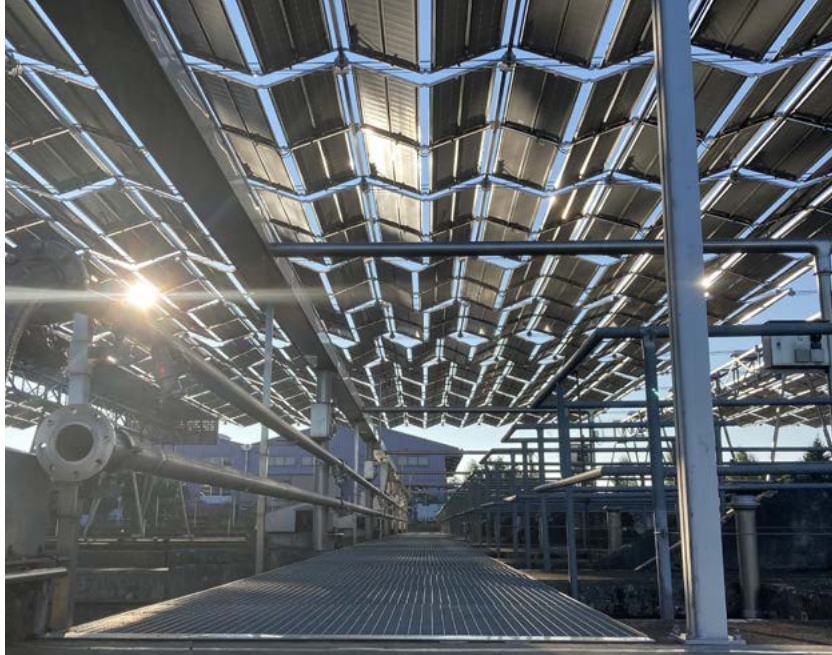
Solkraftwerk Morgental (CH)
